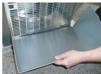
**3** - Fixation du déflecteur en partie haute par les vis **nylon** fournies
