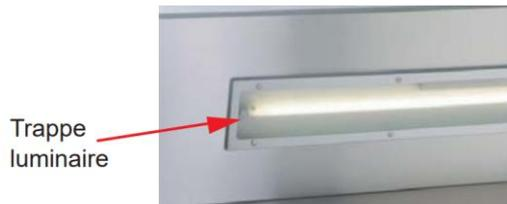
Pour changer les tubes fluorescents dévisser la trappe du luminaire, sortez les tubes des douilles et débranchez les extrémités.
